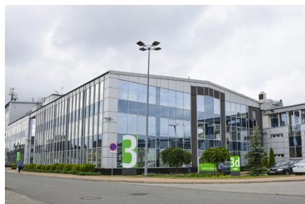
Siedziba TFS w Katowicach
